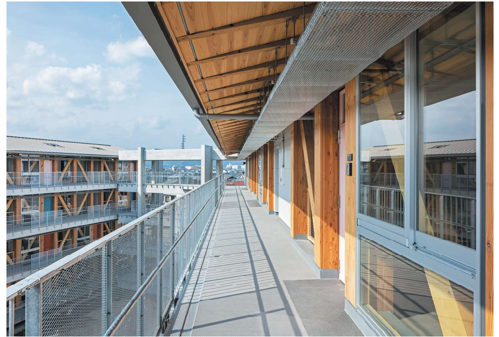
1800mmはね出した共用廊下。配管カバー用のエキスパンドメタルを垂木から吊り下げている。
