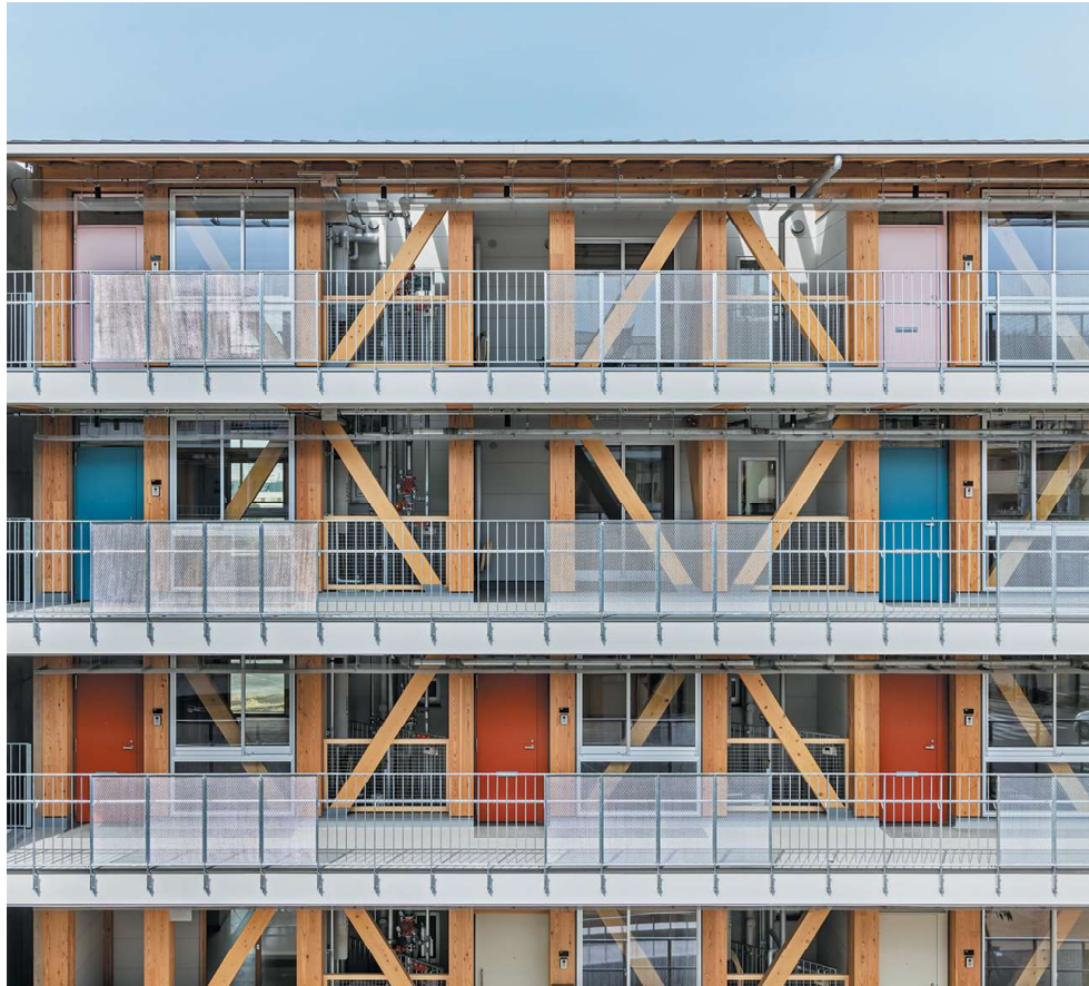
北棟南外観。メインフレームはカラマツ集成材の柱、梁とヒノキの製材の斜材による。
