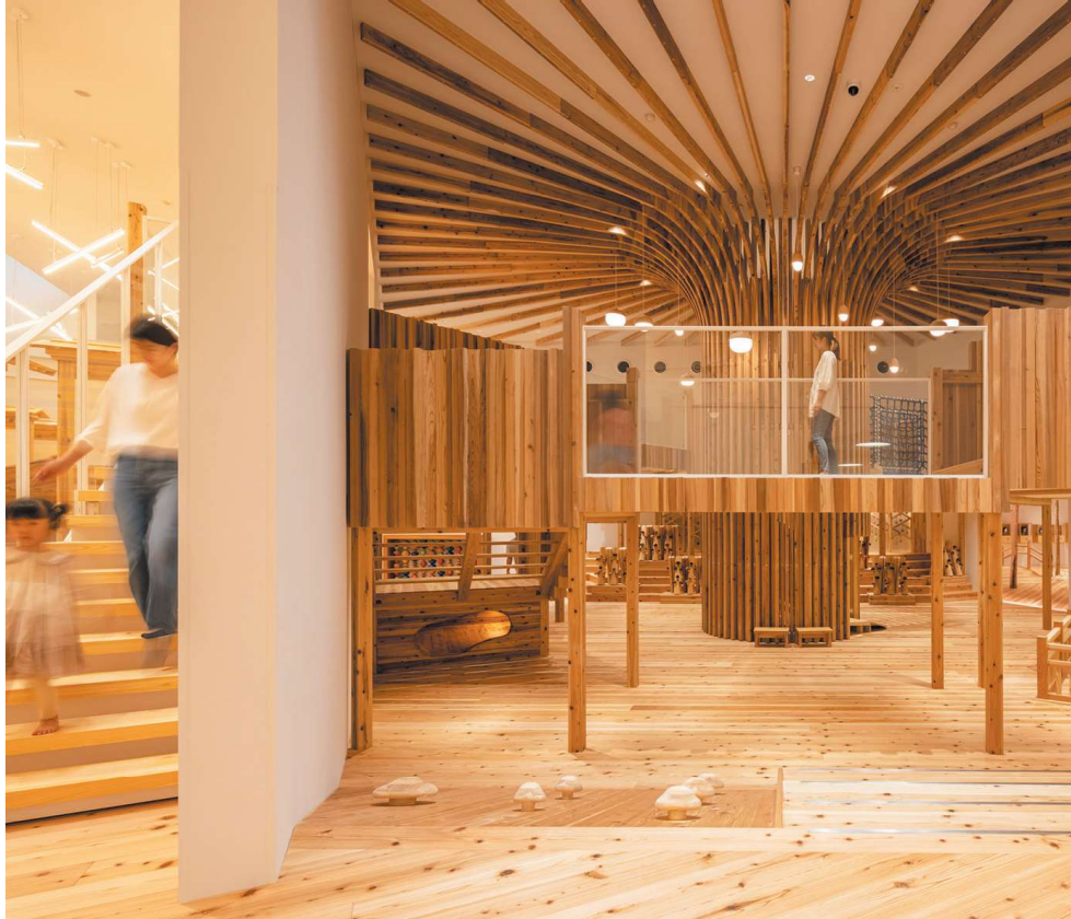
大木をモチーフとした内部が螺旋滑り台となっている遊具兼木製ルーバー。
