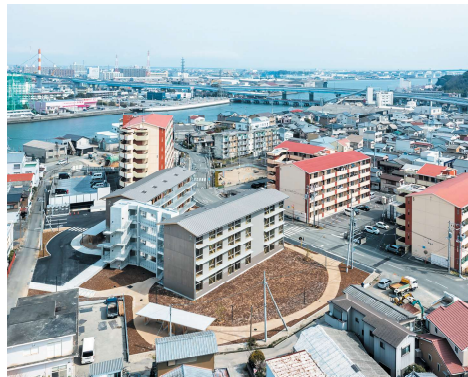
南西側俯瞰。敷地中央に建物を配置し、周辺建物と適切な距離を取り、町にひらく。
