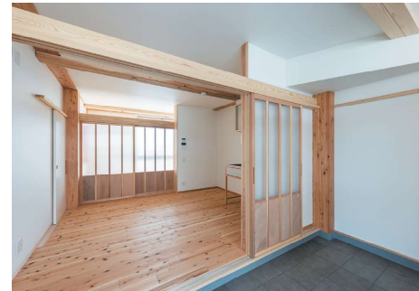
Aタイプ間の間からLDKを見る。内装、建具、家具には徳島県産杉を使用している。
