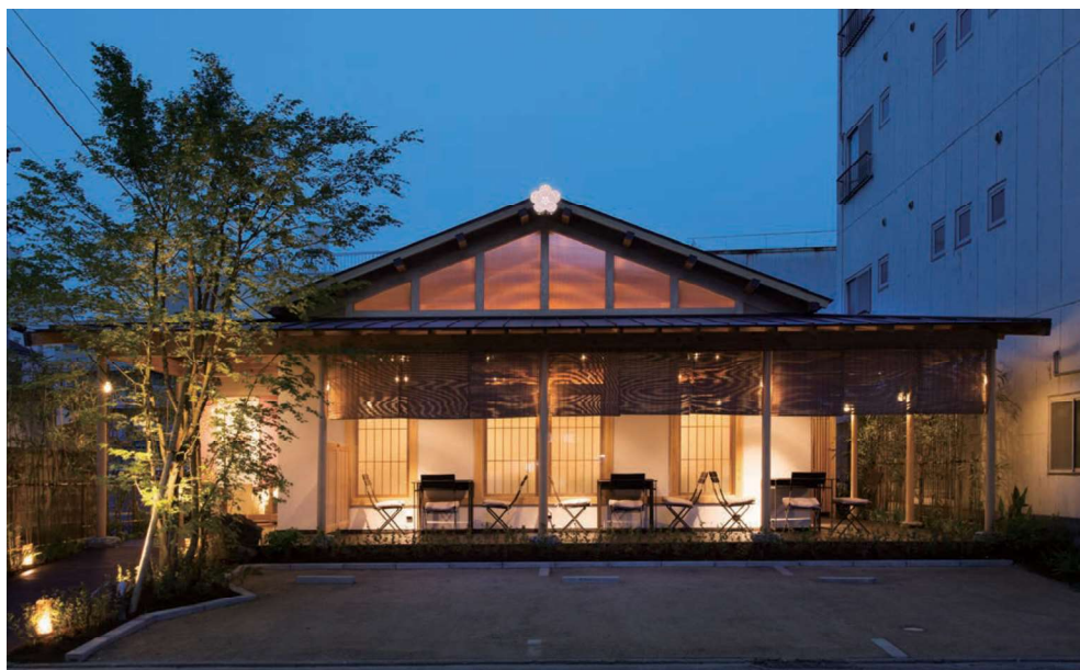
1期施設ファサード
