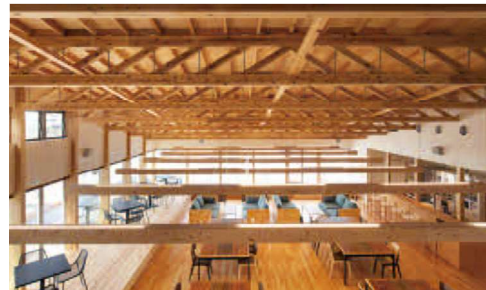
通路-3から休憩室-1を見下ろす
