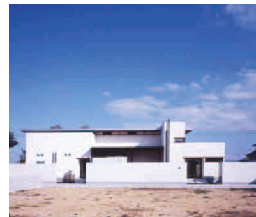
サービス道路とバックヤード
