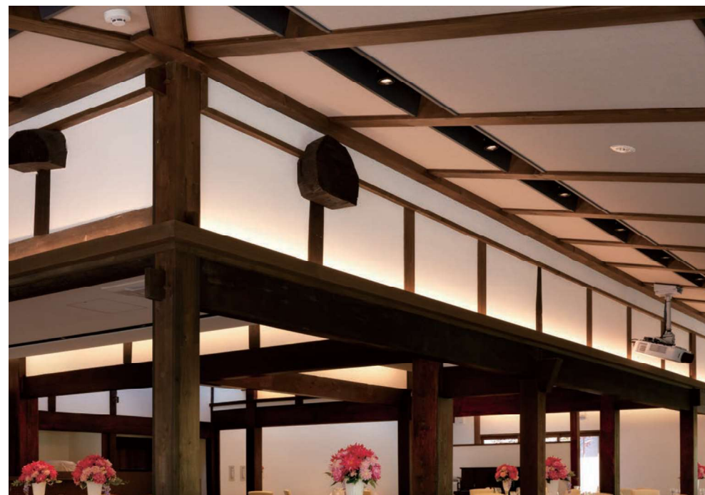
新旧部材の取り合いを素直に見せた仕上
